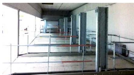
Plattformen zusätzlich mit Fahrblechen aus Aluminium-Tränenblech und Spezialanfahrkeil zur Fahrzeugpositionierung.
