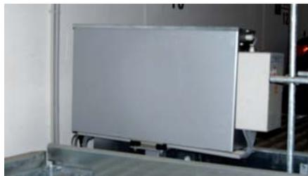
mit Hydraulikverrohrung und Verdrahtung zum Hauptschalter. (Das Unterölaggregat ist leise durch die Motor-Pumpen-Kombination, die Schall absorbiert und gedämmt in Öl liegt)
